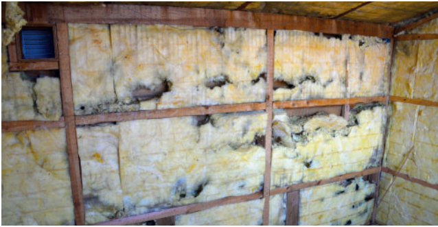
Gl. sauna – isoleringen var delvis ædt af musene
