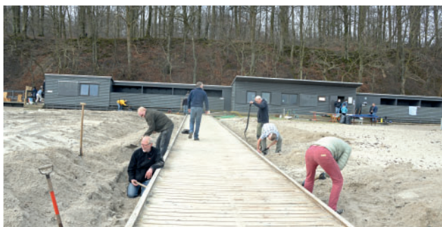
Graverholdet i gang med det hårde arbejde
