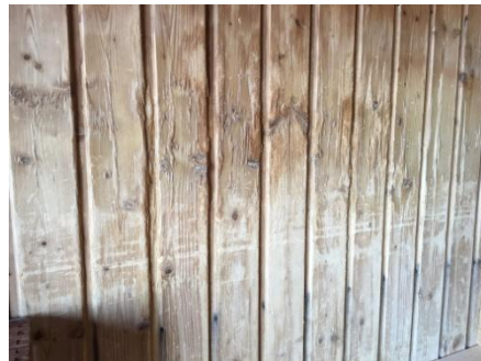
Vægbeklædningen er ved at smuldre væk
